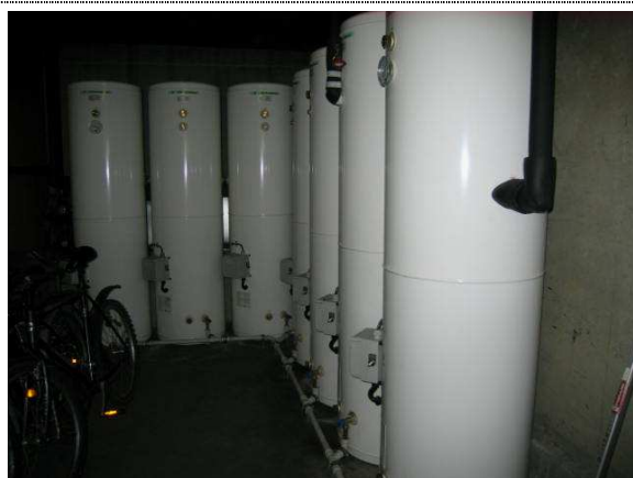
Bilde nr. 20 - Nytt berederanlegg fra 2010.
