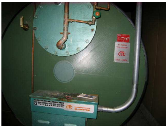
Bilde nr. 15 - Gammelt berederanlegg som skal skiftes.
