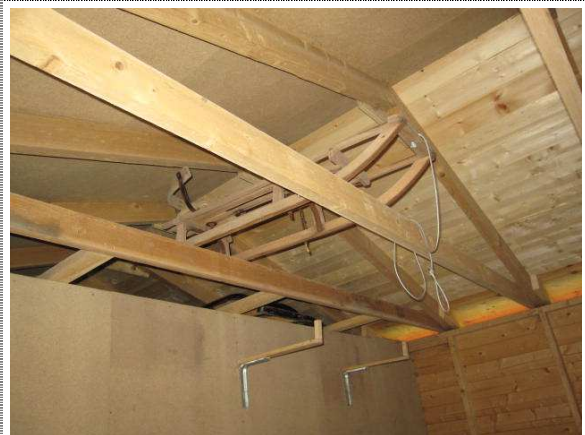
Bilde nr. 30 - Takene på bodene blir skiftet i disse dager. Nytt undertak og papptekking blir lagt.
