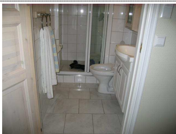
Bilde nr. 4 - Nyere oppgradert baderom.
