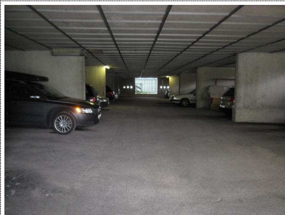
Bilde nr. 39 - Typisk garasje. Generelt noe dårlig belysning.
