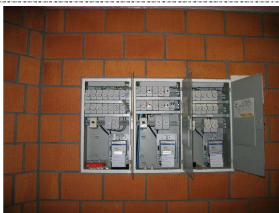
Bilde nr. 6 - Sikringskap er fra byggeåret 1983/1984.
